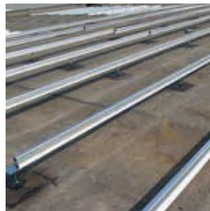
Fissaggio dei profili Omega sulla base regolabile del piedino Fixing of Omega profiles on adjustable foot base
