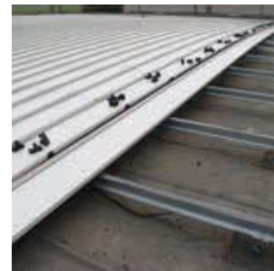
Fissaggio del manto di copertura Roofing fixing
