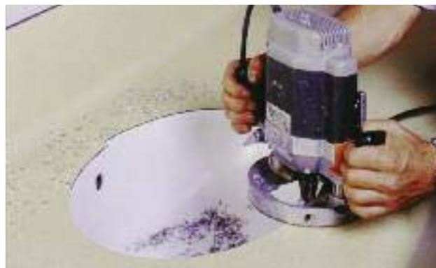
4. Fraisage à fleur du bord dépassant du panneau sur le côté visible à l'aide d'une défonceuse à main (fraise oblique)
