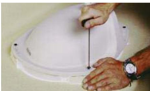
3. Collage de la cuvette de lavabo à la colle PUR et vissage en sous face
