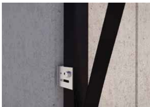
3 _ Application de la bande diélectrique /
