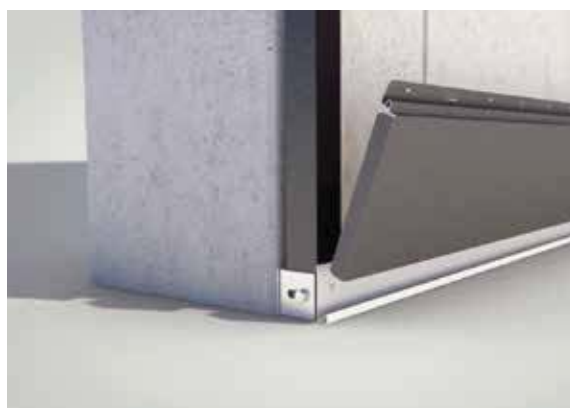
4 _ Fixation du premier panneau à la base de la façade
