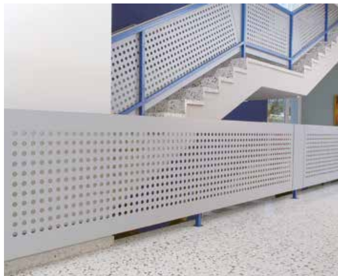
GARDE-CORPS EN PANNEAUX PERFORES FIG. 3
